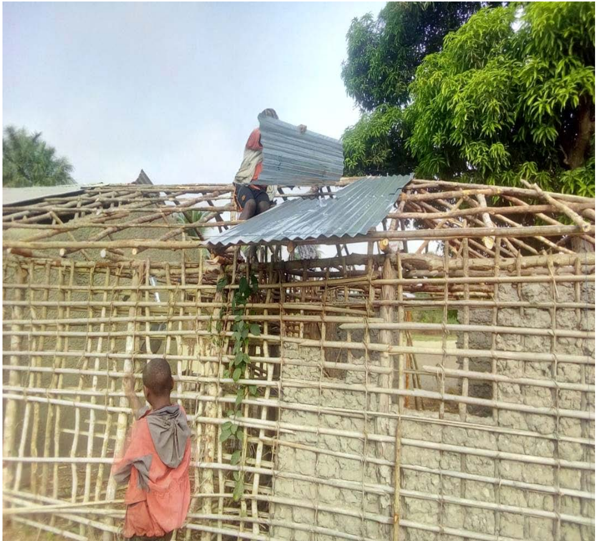
Nytt tak legges. Nye vegger er klargjort for å fylles med sementblanding.
